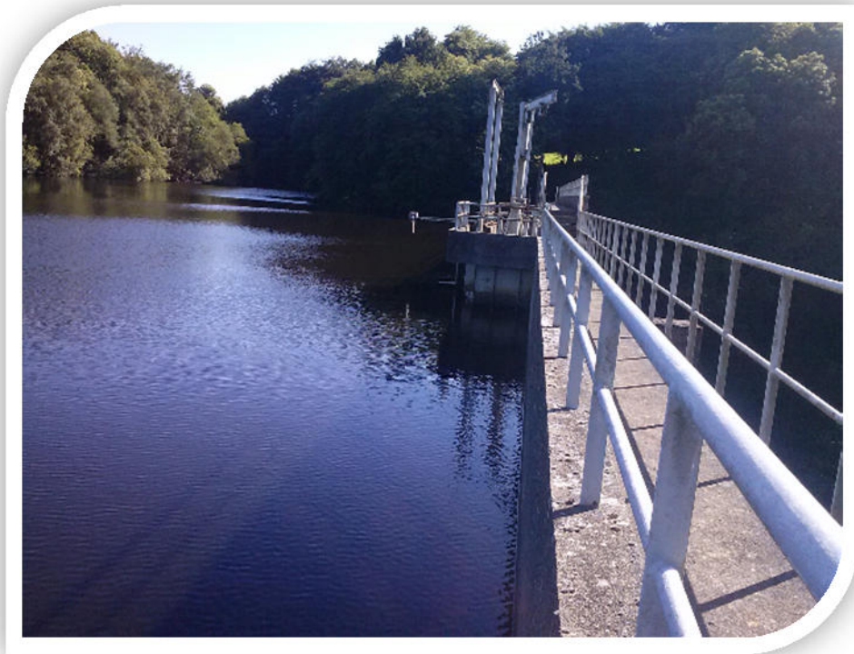
Barrage de Mireloup
