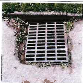
une grille d'évacuation des eaux pluviales
